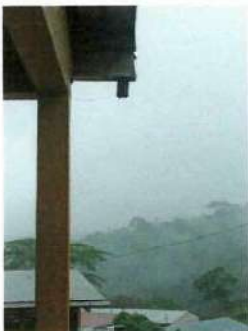
Foto 11: Se observa que las bajadas de agua ya no son funcionales y es necesario sustituir algunos canales picados por oxido.
