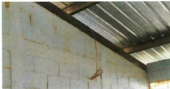
Foto 14: Sustitución de cable electrico y focos que ya no estan funcionando.
