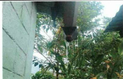
Foto 12: Se observa que las bajadas de agua ya no son funcionales y es necesario sustituir algunos canales picados por oxido.
