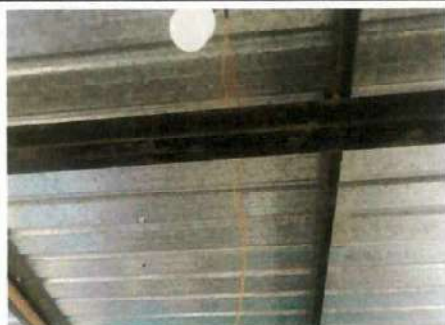
Foto 17: Sustitución de cable electrico y focos que ya no estan funcionando.
