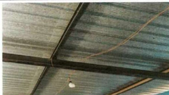
Foto 16: Sustitución de cable electrico y focos que ya no estan funcionando.
